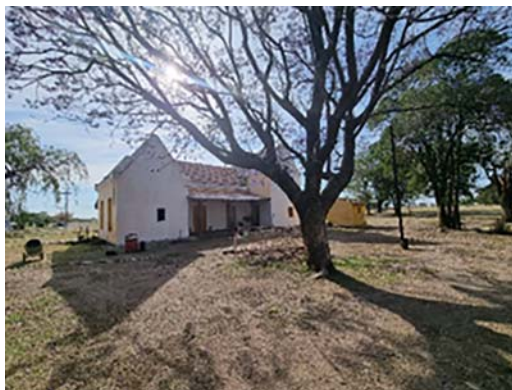
Imagen N° 17: Vista trasera de Estación Sarmiento.
