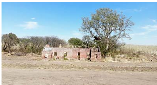
Imagen N° 26: Parador ferroviario Km. 784. Sinsacate. Estado de conservación: Ruinas. Fotografía del autor. Fecha de toma: 22 de noviembre de 2022
