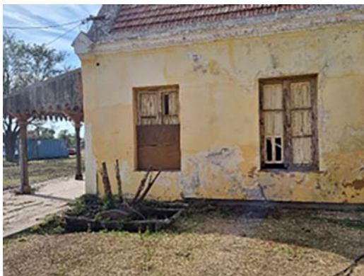
Imagen N° 16: Vista lateral de Estación Sarmiento.
