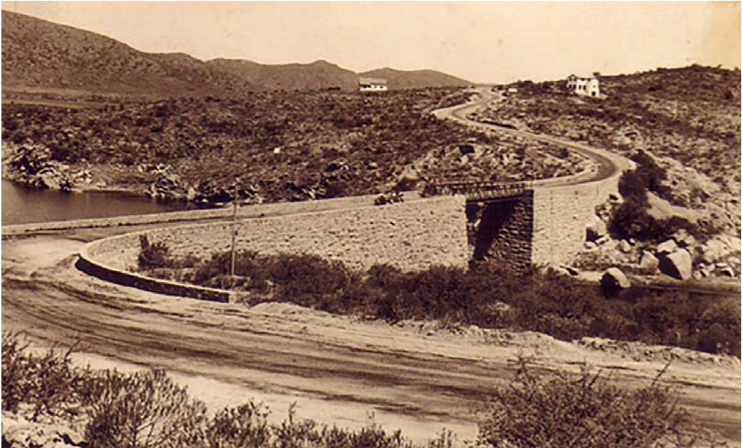
Figura 7. Puente Negro (1930). Fuente: Colección propia.
