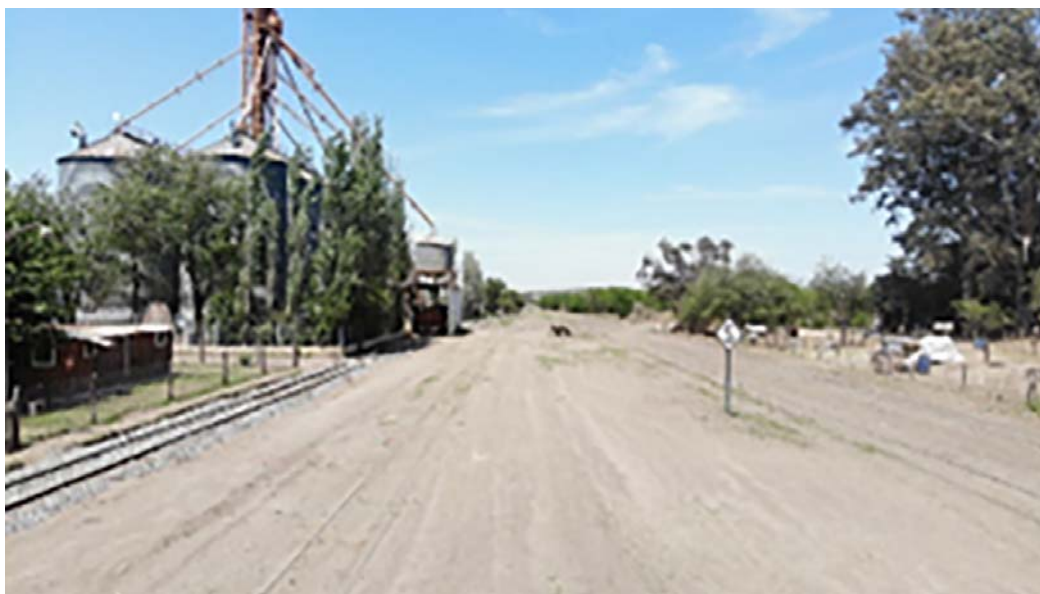
Imagen N° 25: Estación Caroya y Silos de Carga con línea ferroviaria anexada. Estado de conservación: Bueno, en estado de renovación. Fotografía del autor. Fecha de toma: 22 de noviembre de 2022
