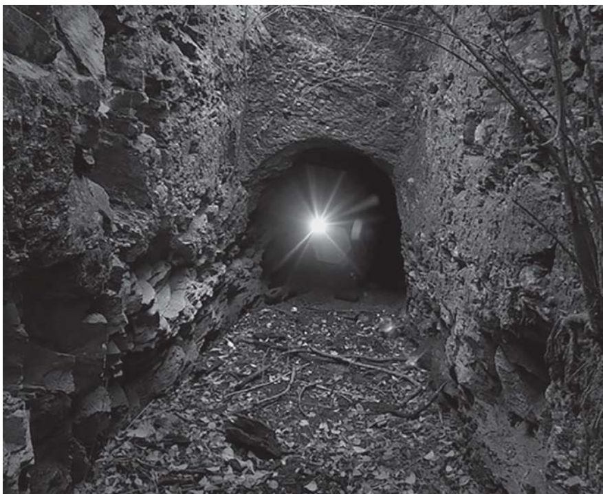
Fotografía del Túnel en el canal Las Rosas - siglo XIX - Sacada el 10 de noviembre de 2019, por Diego Del Bosco.
