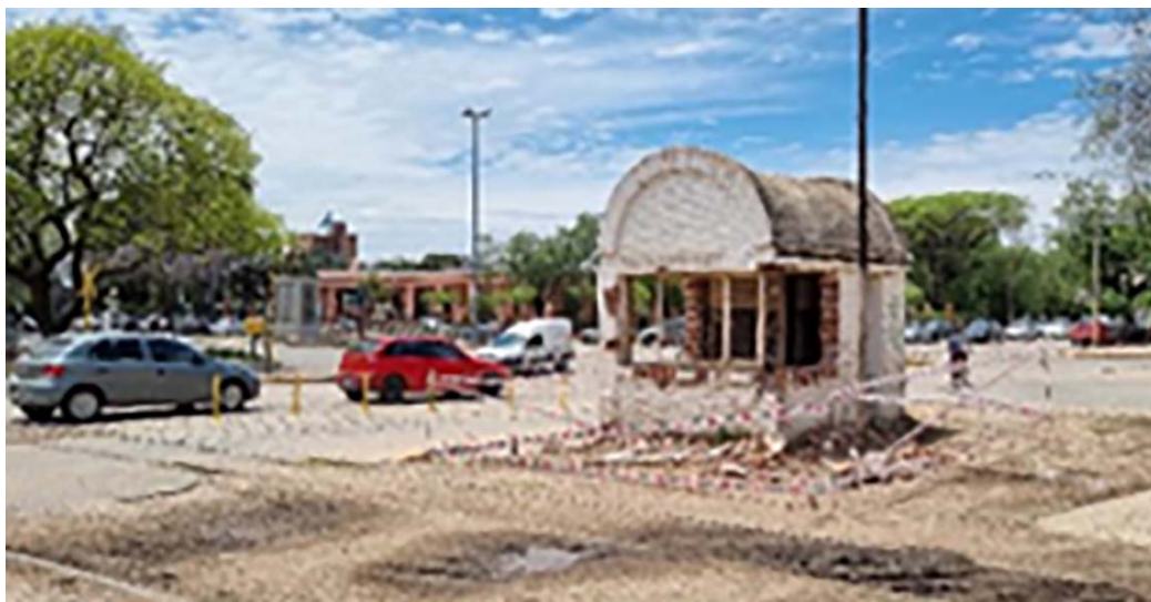
Imagen N° 14: Garita de paso a nivel. Calles Julio A. Roca y Av. Juan B. Justo Estado de conservación: Demolido. Fotografía del autor. Fecha de toma: 2 de noviembre de 2021
