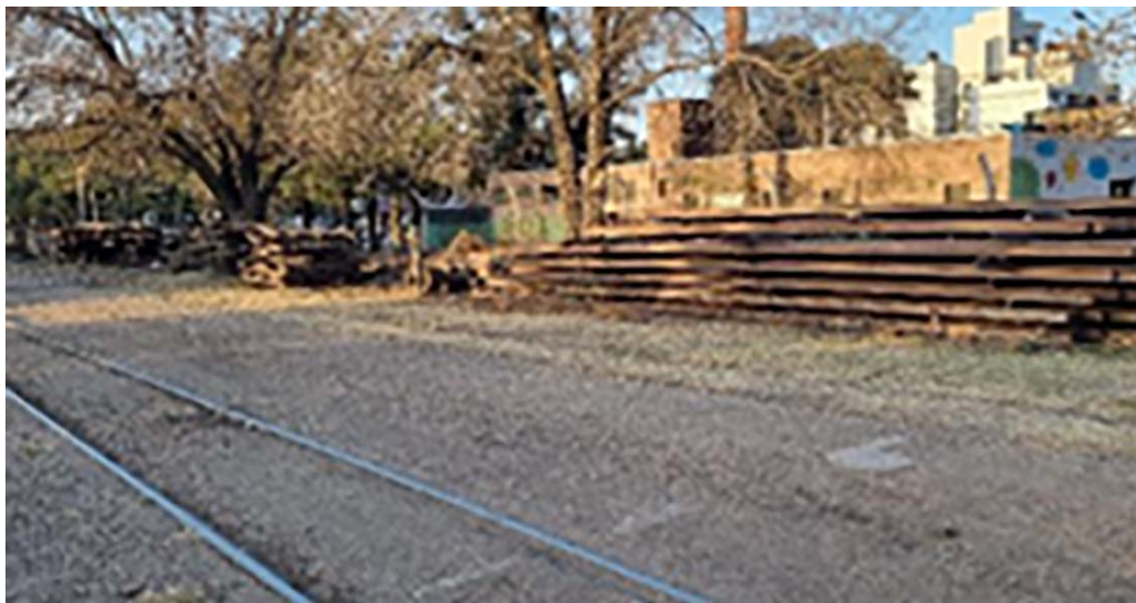
Imagen N° 11: Rieles y durmientes en desuso Estado de conservación: Malo.
