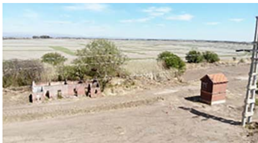
Imagen N° 28: Parador ferroviario Km. 784 y cabina de señales. Sinsacate.
