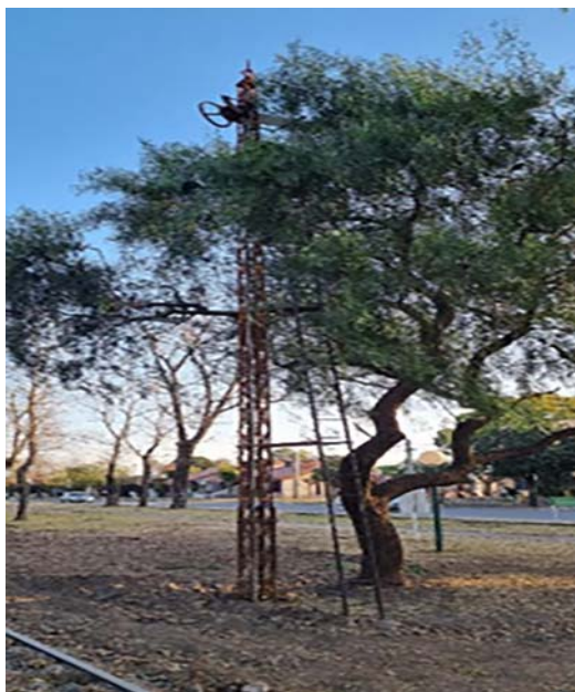
Imagen N° 7: Torre de Telégrafo en desuso. Estado de conservación: Intermedio. Fotografía del autor. Fecha de toma: 14 de julio de 2022
