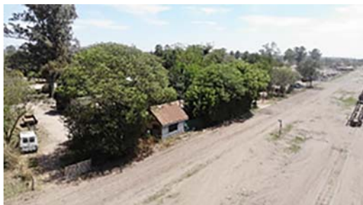
Imagen N° 23: Estación Caroya. Estado de conservación: Malo/Abandonado. Fotografía del autor. Fecha de toma: 22 de noviembre de 2022
