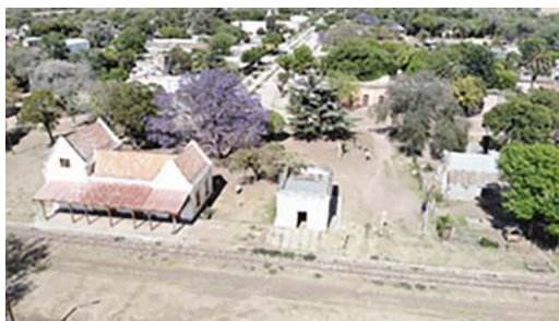
Imagen N° 19: Vista aérea de Estación Sarmiento y casa del guarda.
