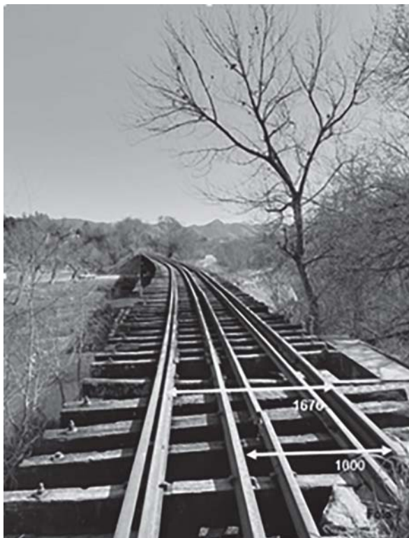
Puente sobre el río Suquía entre Dumesnil y La Calera donde se observa la trocha mixta.
