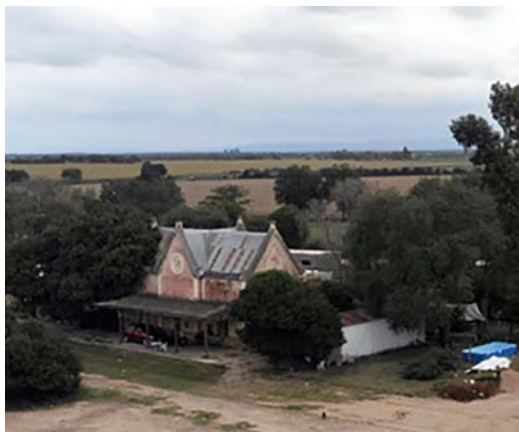
Imagen N° 2: Estación ferroviaria General Paz. Estado de conservación: Malo. Fotografía del autor. Fecha de toma: 24 de abril de 2023
