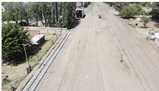
Imagen N° 24: Líneas ferroviarias de Estación Caroya. Estado de conservación: 2 líneas en estado de abandono. 1 línea en estado de renovación. Fotografía del autor. Fecha de toma: 22 de noviembre de 2022
