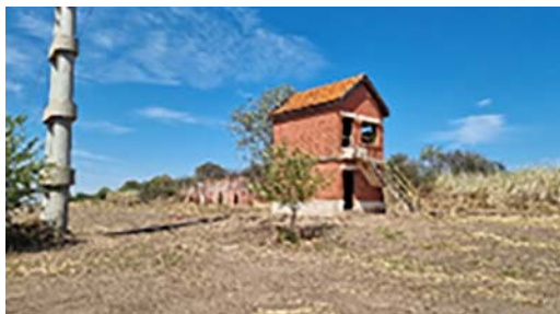
Imagen N° 29: Cabaña de señales, vista frontal. Parador ferroviario Km. 784. Sinsacate.
