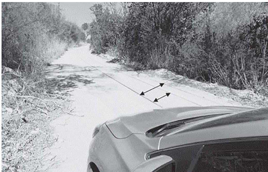
Camino de canteras sobre la zona de vías mixtas entre el puente sobre el río Suquía y Av, Ejercito Argentino.
